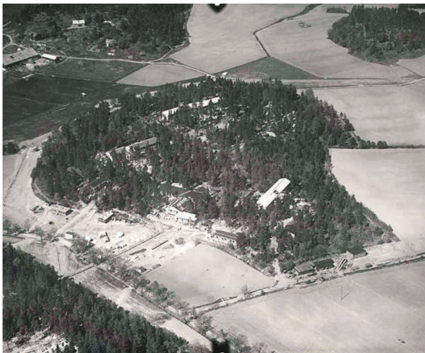
FRA:s anläggning på Lovön 1943.
